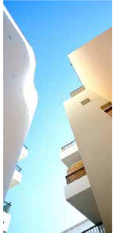
Résidence Rues Berger et Moreau Édith Girard Architecte
