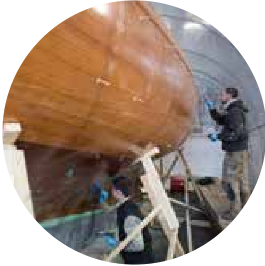
Chantier du Guip
