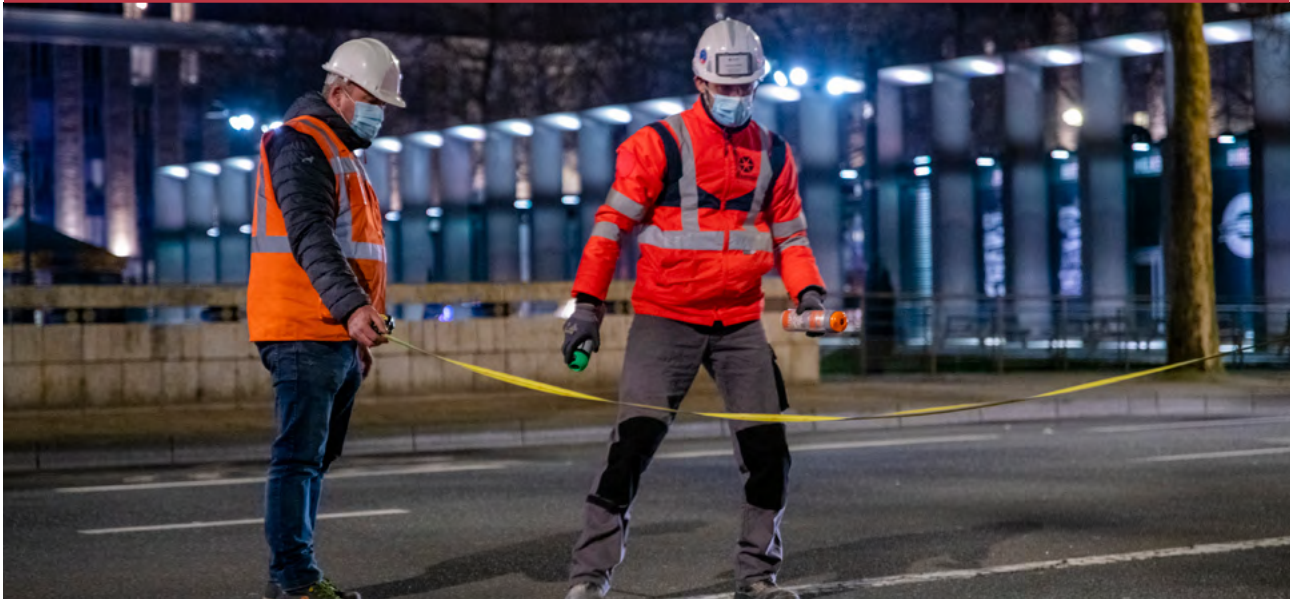
Essais de charge du pont Clémenceau - Crédit : Matthieu Le Gall / Brest métropole
