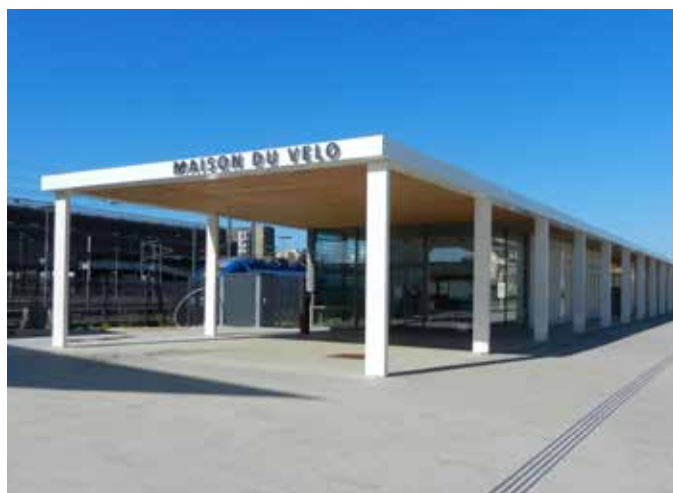
À Saint-Brieuc, sur le site du pôle d'échanges de la gare, la Maison du vélo offre différents services aux cyclistes. Photo : Adeupa
