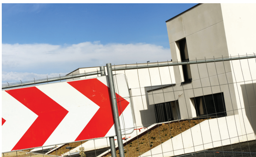
Lotissement en construction - Crédit : Jean Yves Guillaume - Brest métropole
