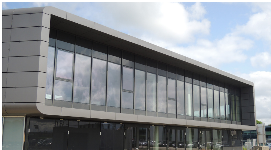
Construction du siège d'AC3 (Prat-Pip Nord - Guipavas)
