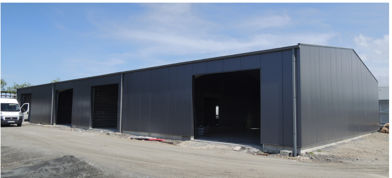
Construction d'ateliers-relais (Parcou - Ploudaniel)
