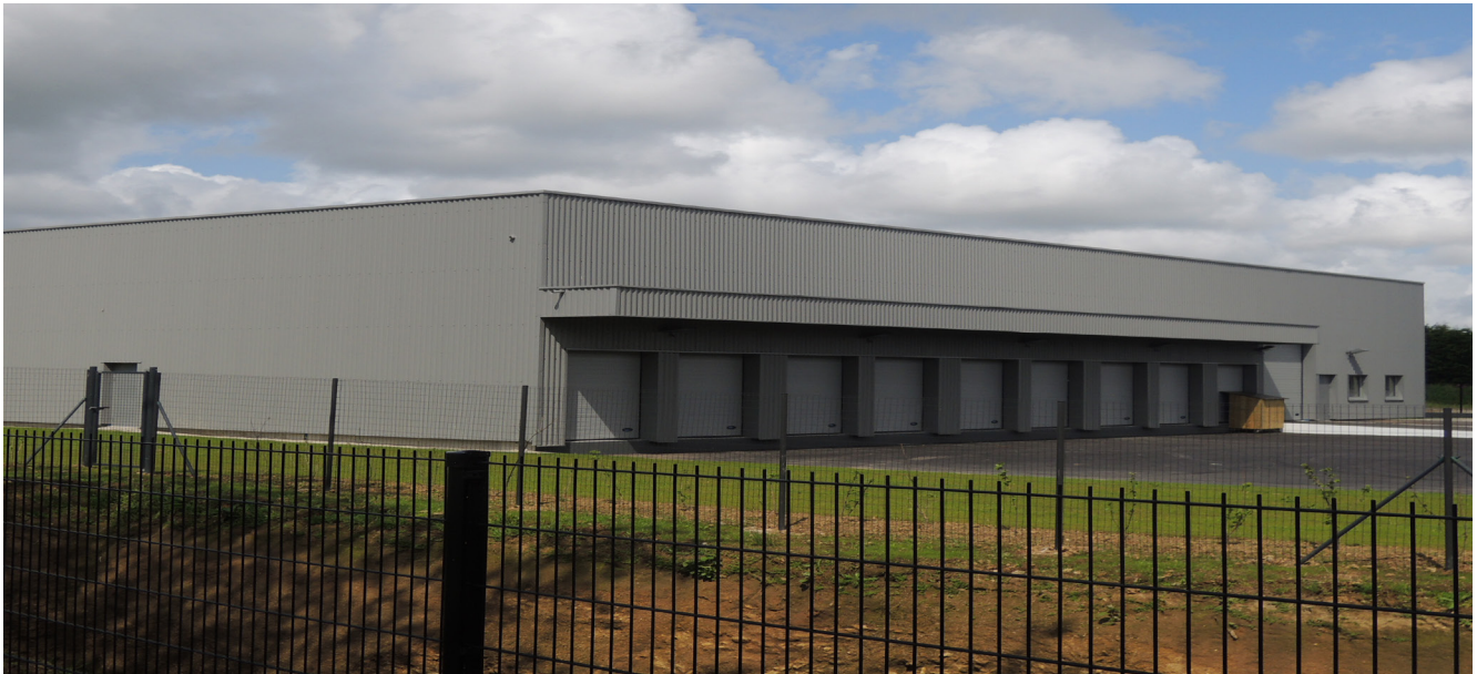
Plateforme de distribution de Fiducial (Saint-Thudon - Guipavas)
